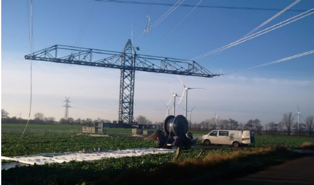
Abbildung 8: 380-kV-Freileitungsprovisorium (Gitterstahl) für zwei Systeme (mit Auflast)
