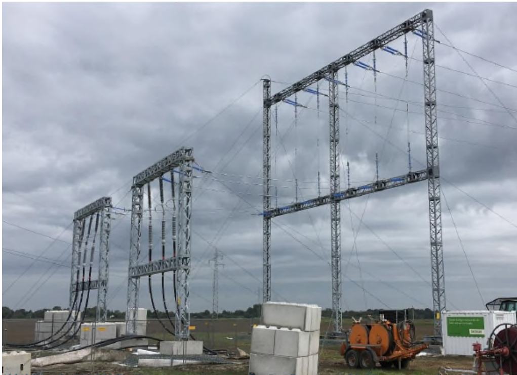
Abbildung 6: 110-kV-Freileitungsprovisorium für vier Systeme, inkl. Übergangsanlage Baueinsatzkabel (inkl. Abankerung)
