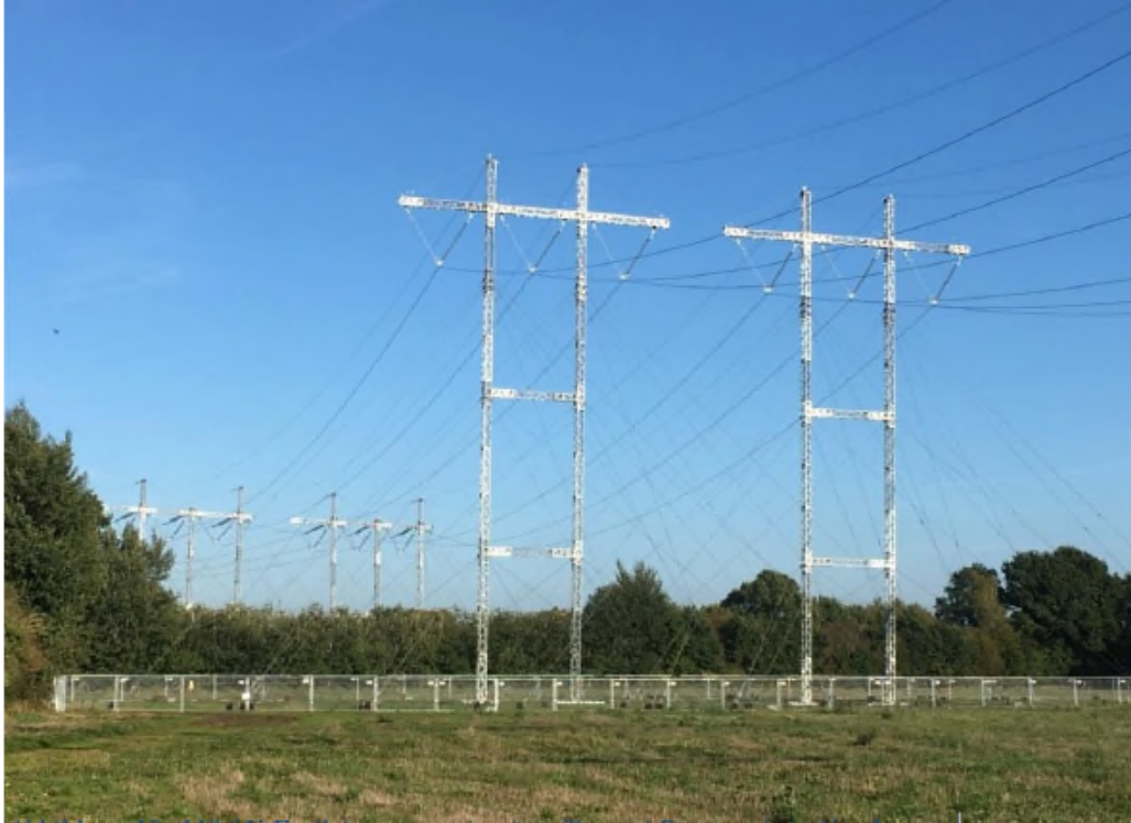
Abbildung 7: 110-kV-Freileitungsprovisorium für 2 Systeme (mit Abankerung)
