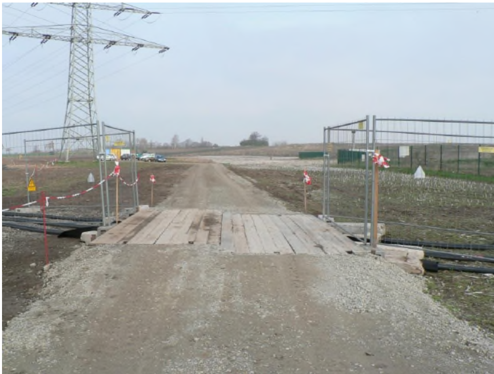
Abbildung 10: Beispiel einer Kabelprovisoriums über einen Weg
