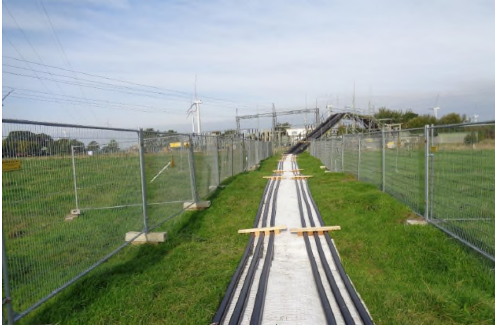
Abbildung 9: Beispiel einer Kabelbrücke über einem Weg
